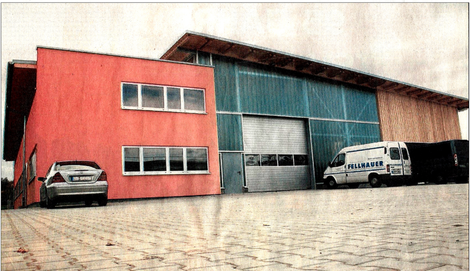
SEINER BESTIMMUNG ÜBERGEBEN wird am morgigen Samstag der neue Östringer Bauhof im Gewann „Erlenbrüchle“. 22 Mitarbeiter finden in den 1 100 Quadratmeter großen Gebäude und dem 5 800 Quadratmeter großen Grundstück nun optimale Arbeitsbedingungen vor.
